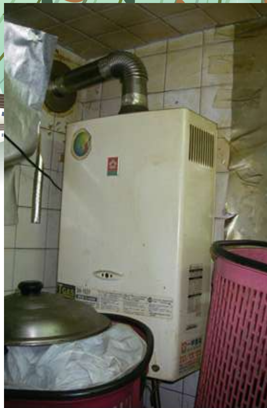
▲照片 7 加裝強制排氣風管
