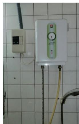
瞬熱式電熱水器
