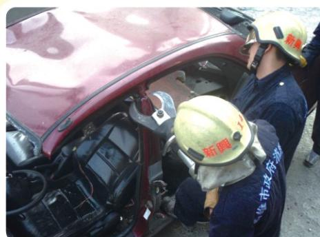
■ 消防人員操作油壓破壞工具
