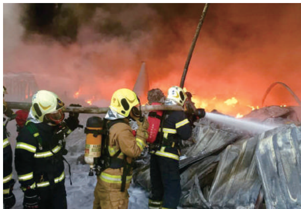
鐵皮建築具有延燒速度快之特性（照片為消防局副局長蔡致模提供）
