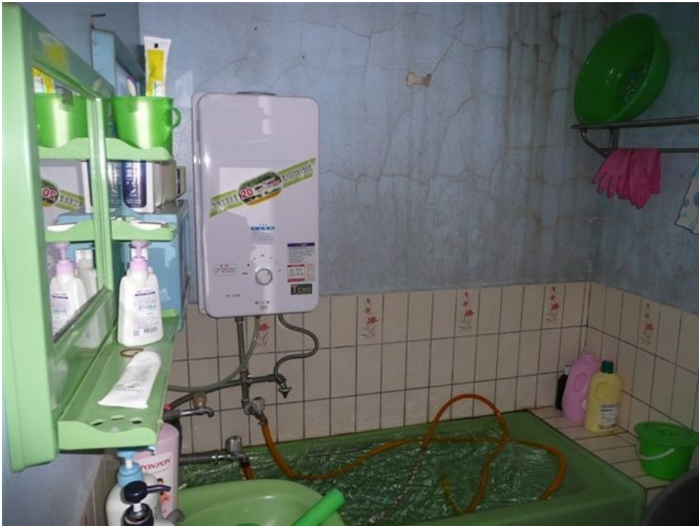
CF 式熱水器未裝設排氣管範例圖
