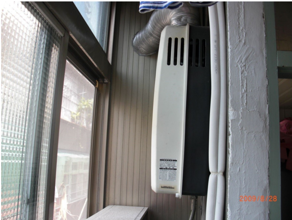
CF 式熱水器裝設錯誤之排氣管範例圖
