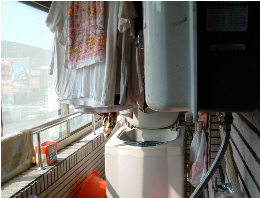
RF 式熱水器裝設於加蓋陽臺範例圖
