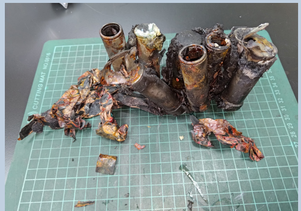
▲ 圖 4、鋰電池火災常造成電池頂部的安全閥破裂，內部的電解液及極板噴出情形
