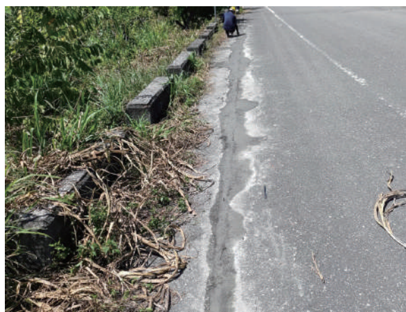
圖 4-81、富源溪瑞美堤防緊急修復完成
