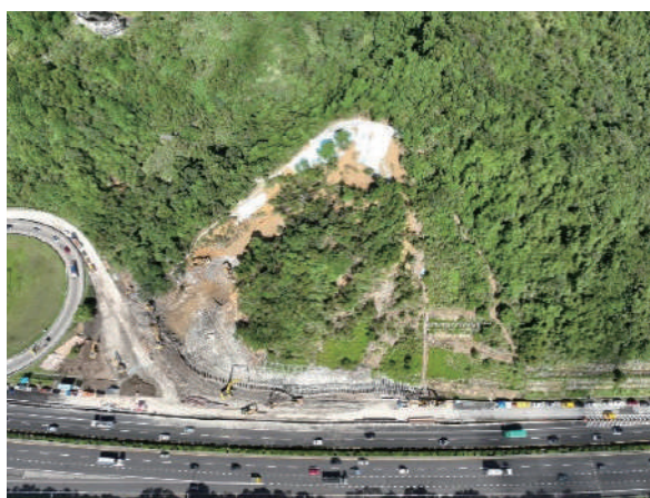
圖 4-84、國道 1 號南下 10.1k 邊坡坍滑
