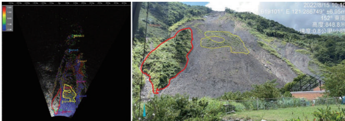
圖 4-26、新竹縣尖石鄉秀巒崩場地監測之雷達影像（左）與現場目標對照圖（右）
