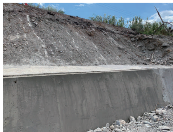
圖 4-80、崙天溪右岸堤防緊急修復完成
