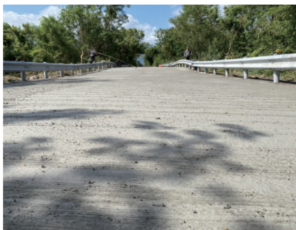
圖 4-79、卑南溪瑞源堤防緊急修復完成
