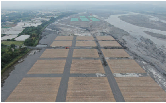
圖 4-61、屏東里港大橋鋪設稻草蓆之揚塵防制(護)
