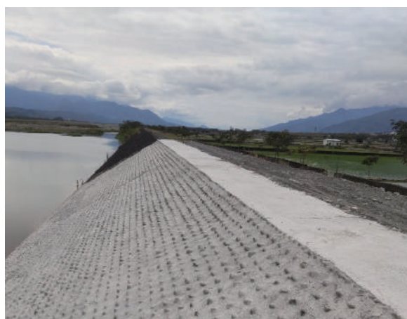
圖 4-83、秀姑巒溪大禹堤段復建完成
