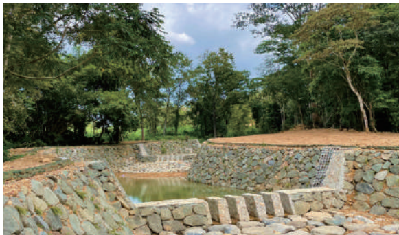
圖 4-8、土砂災害防治工程（后湖橋上游野溪） 資料來源：農業部
