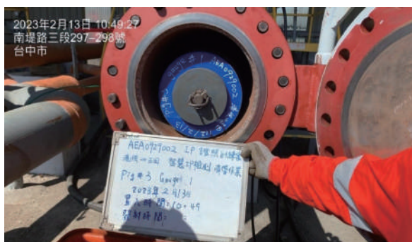
圖 4-1、精密檢測儀器放入管線內 資料來源：經濟部
