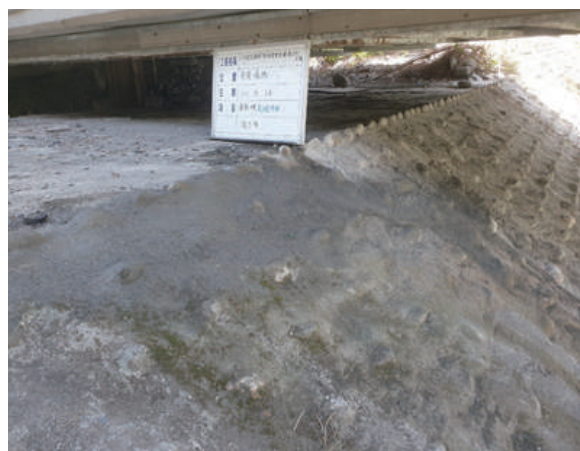
圖 4-82、秀姑巒溪安民堤防緊急修復完成
