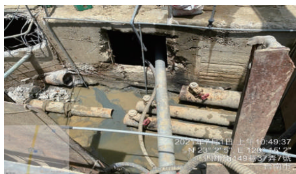
圖 4-2、依據檢測結果進行換管作業 資料來源：經濟部
