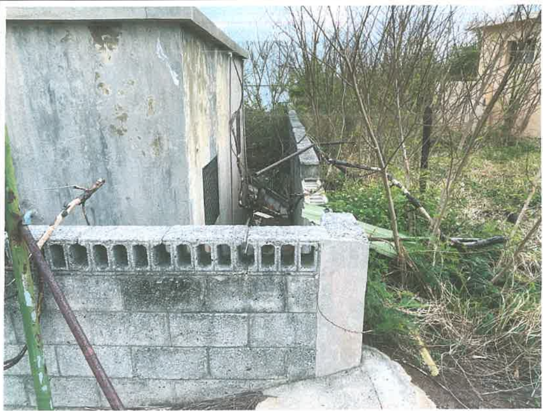
說明：占用物-空心磚圍牆及牆內庭院
