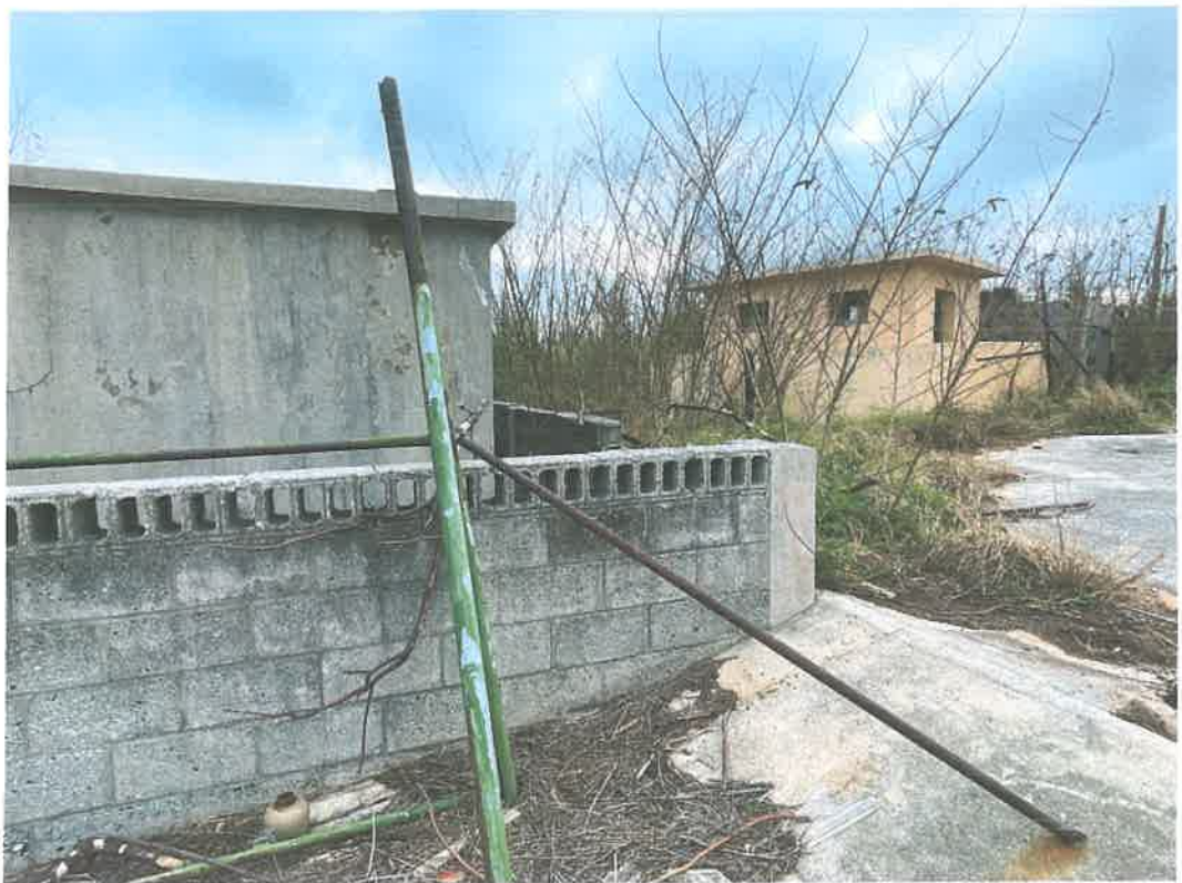
說明：占用物-空心磚圍牆及牆內庭院
