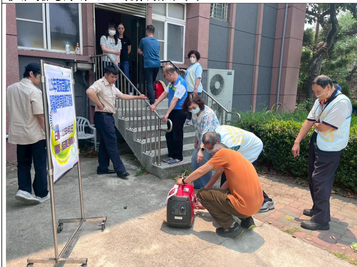
移動式發電機-搶修組組員實機操作 (4)
