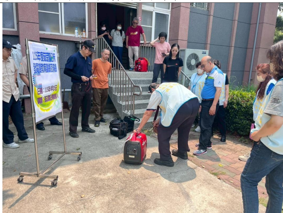
移動式發電機-防災協作中心組長實機操作 (2)
