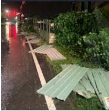
災害狀況(波浪板散落)
