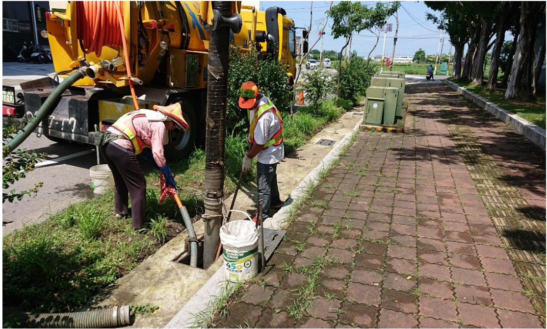
108年0718豪雨後清潔隊清除溝渠情形照片
