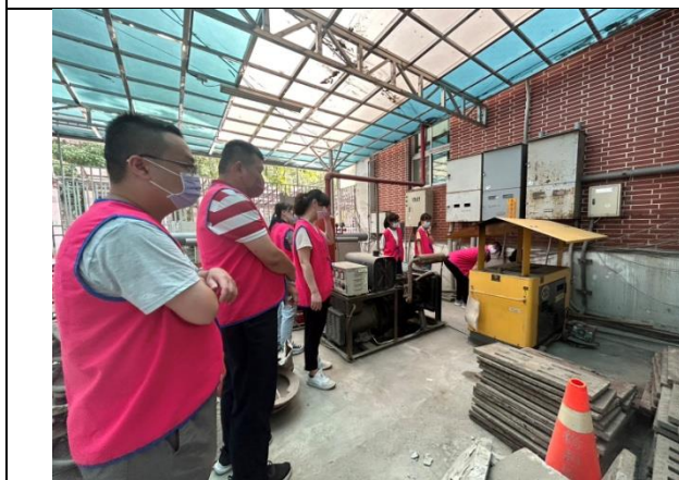
說明：大型柴油發電機教學與操作
