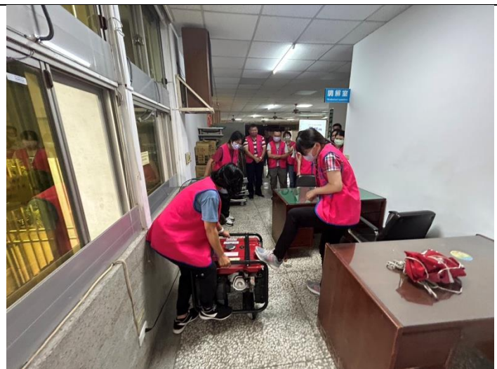
說明：小型發電機實際操作
