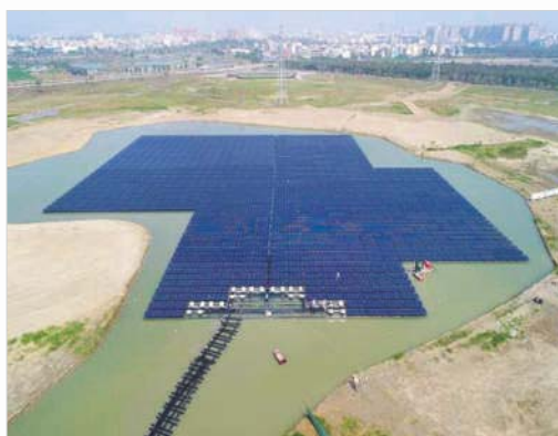
典寶溪 B 區滯洪池浮力式太陽光電
