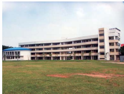
大寮區潮寮國中校舍新建工程
