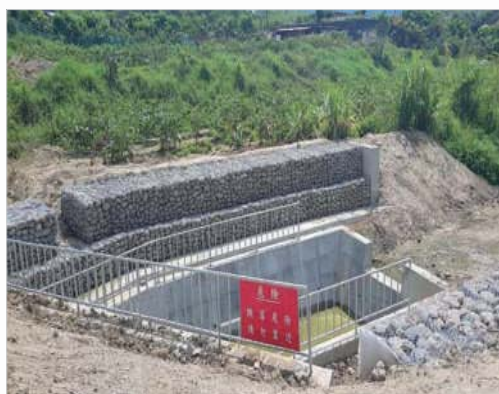
田寮區七星里大山橋排水護岸災修工程
