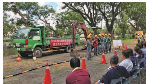
水電燃煤氣管挖施工作業安全觀摩
