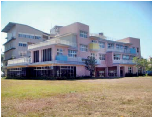
鹽埕區鹽埕國中第2期校舍新建工程
