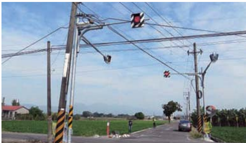
太陽能警示設施
