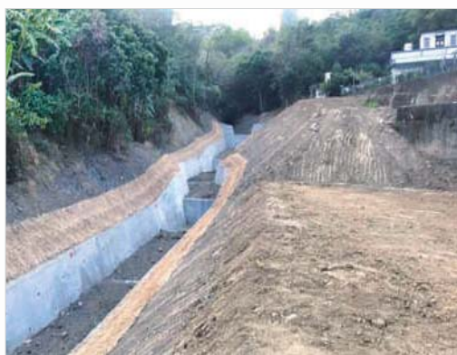
杉林區木梓里玄龍宮下方野溪治理工程
