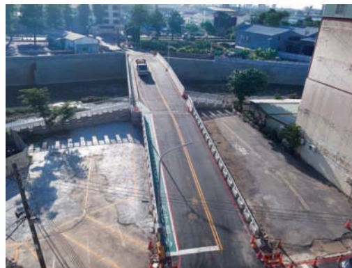
仁武區興亞橋改建工程
