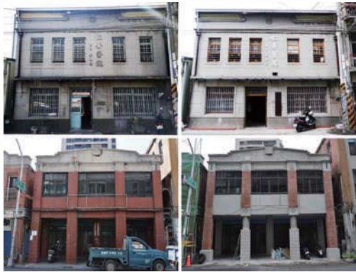
岡山仁壽醫院及鼓山一路 9 號成功活化照片
