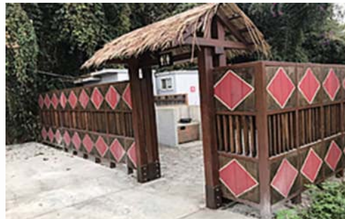
那瑪夏區觀光遊憩設施整建工程
