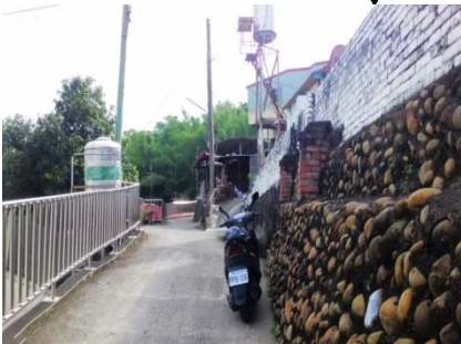
1.德義街 14 巷 2.人煙稀少，照明不足出入複雜
