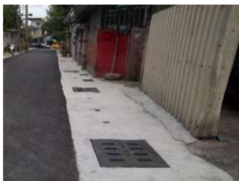
自強里巷道路溝改善-後
