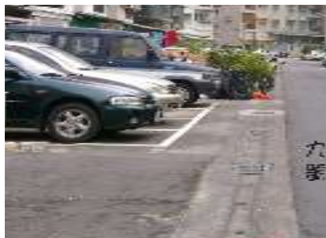
雄峰里路溝修繕-前
