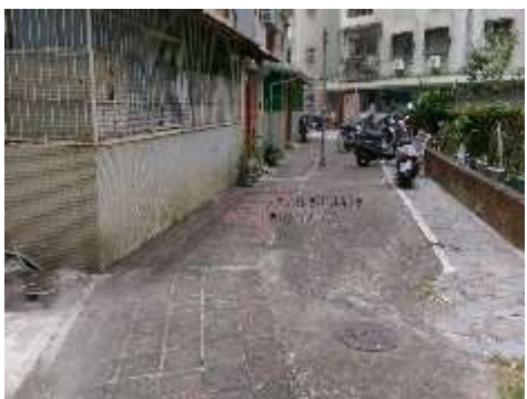
雄峰里人行道修繕-前
