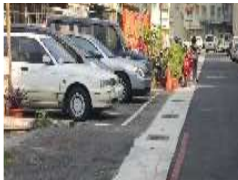
雄峰里路溝修繕-後
