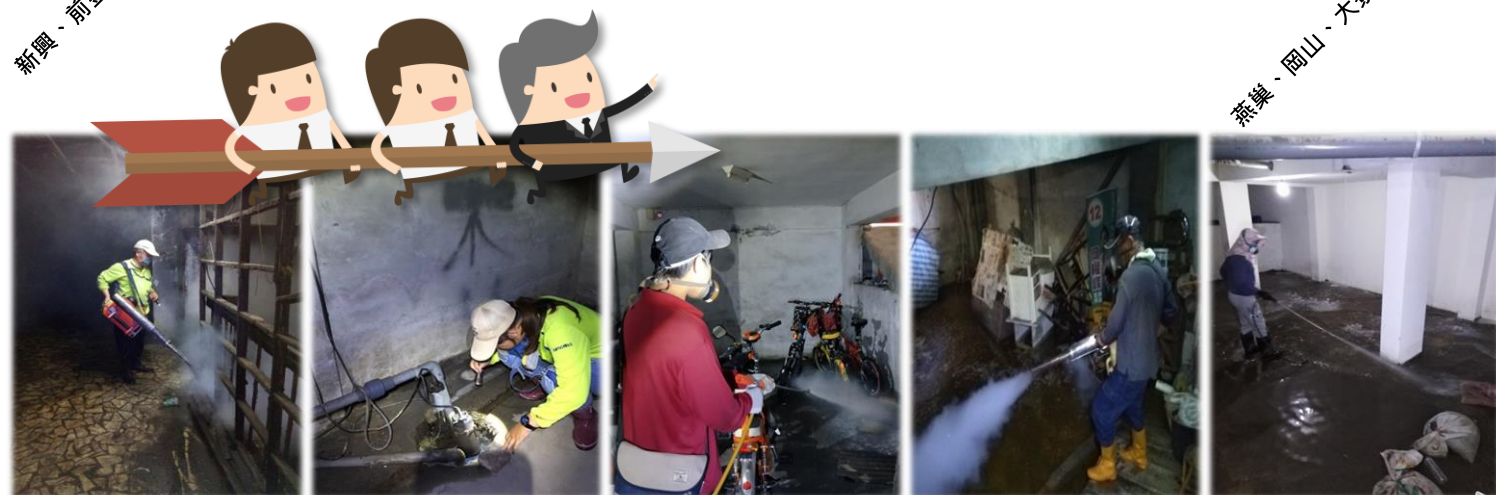
圖、積水地下室化學防治作業
