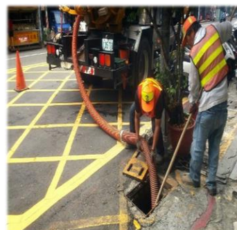
圖、陽性水溝溝壁沖刷
