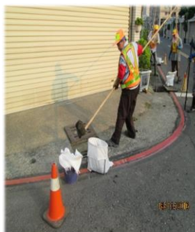
圖、重點水溝疏通
