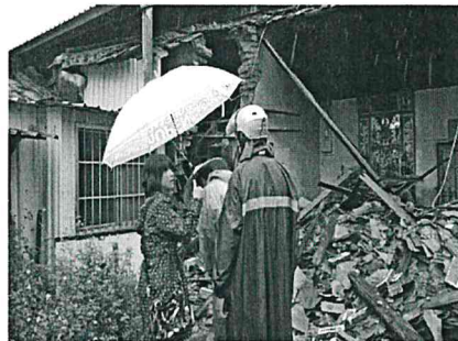
里幹事偕同區公所人員於風災後巡視塌陷房屋
