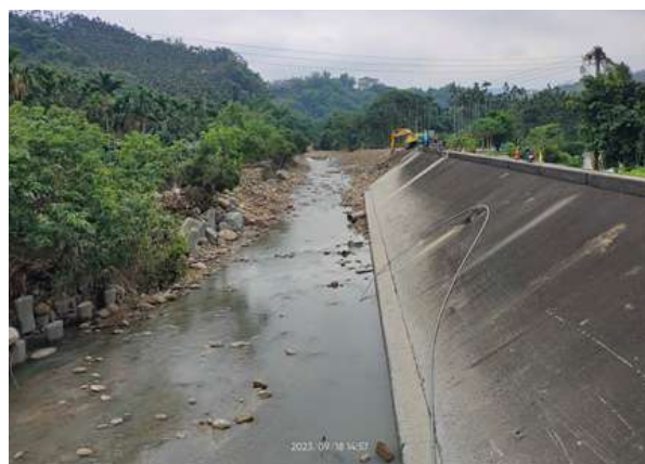
圖 3-96、赤蘭溪仙姑娘護岸緊急修復完成
