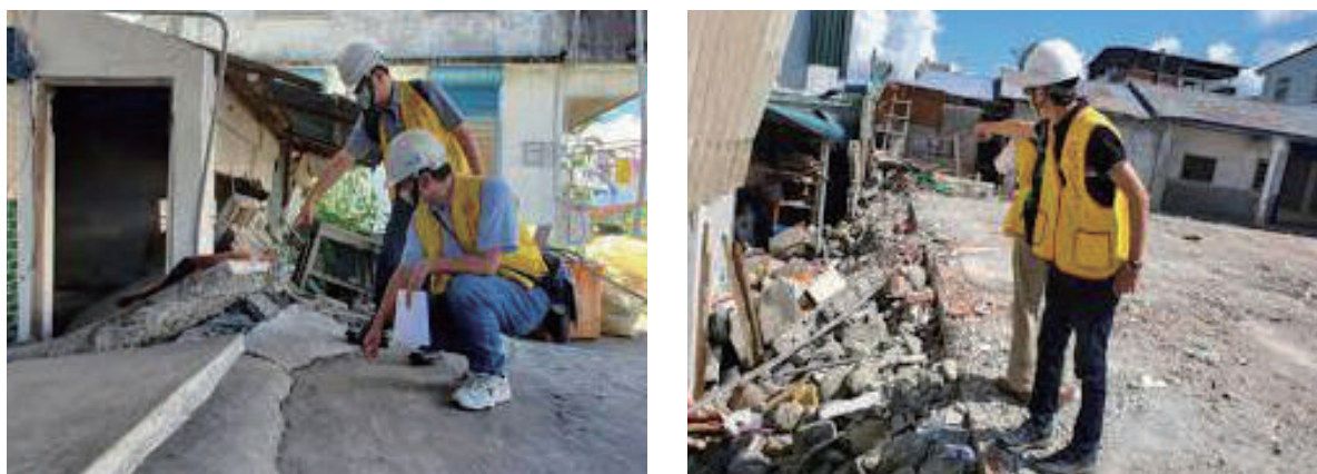
圖 1-19、危險建築物緊急評估作業
