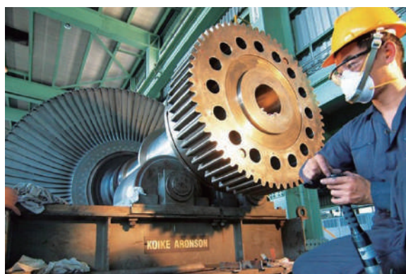
圖 3-4、因應夏季用電需求，確保機組穩定及發電效率，台電安排非夏季期間進行歲修
