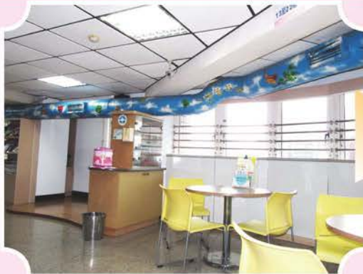
空調管子外露有壓迫感
