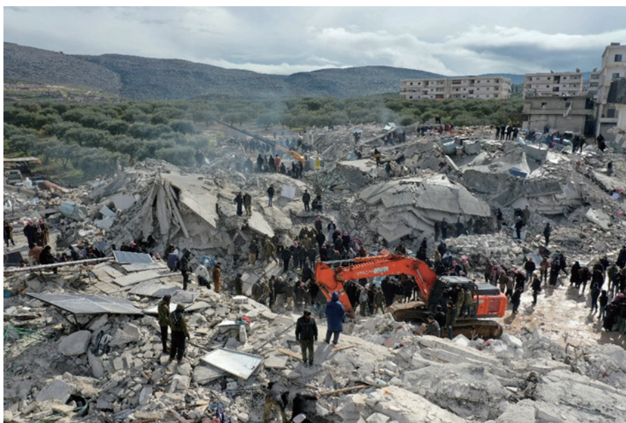
圖 1-6、土耳其地震後建物毀損與拆除現況
