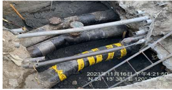
圖 3-7、油料管線依檢測結果進行換管作業
