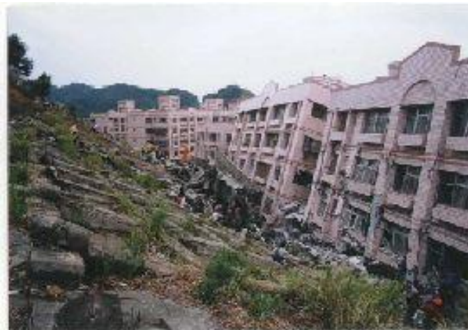
圖 8 1997 年溫妮颱風造成林肯大郡坡地崩塌災情
