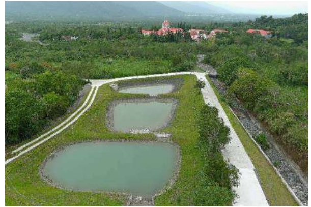
圖 3-21、光復鄉大全村自強外役監滯洪農塘改善工程榮獲公共工程金質獎佳作
