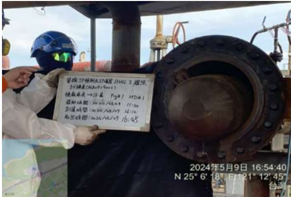
圖 3-9、精密檢測儀器放入管線內
