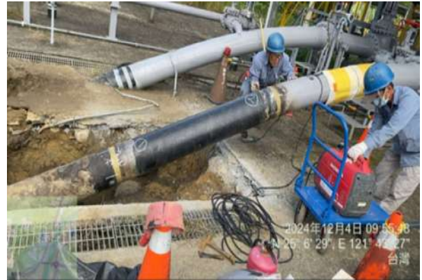
圖 3-10、依據檢測結果進行換管作業
