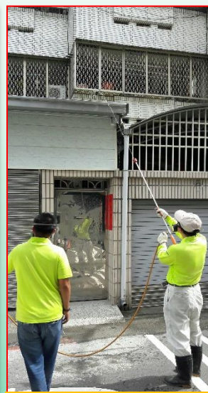
屋沿溝噴藥作業
